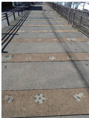
写真左から 密集する車止め 駒場運動公園脇の暗渠
