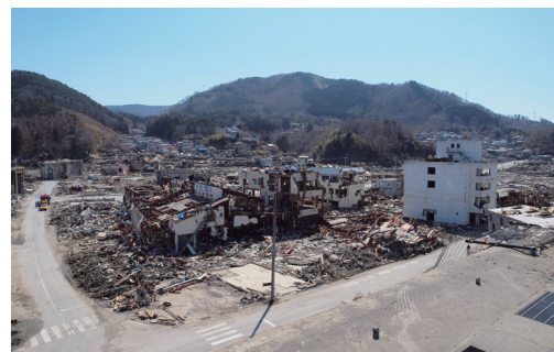
女川町立病院から見た被災した街なみ
