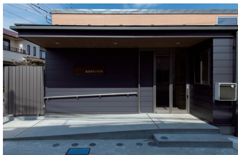
正面玄関へのスロープ
